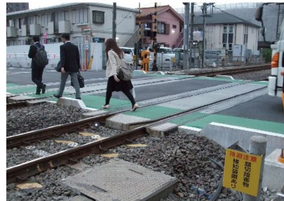
↑歩行者通路が狭く危険な状況
