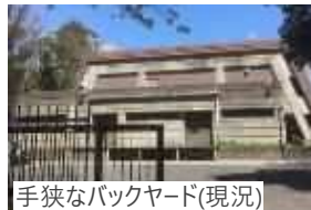
手狭なバックヤード(現況)
