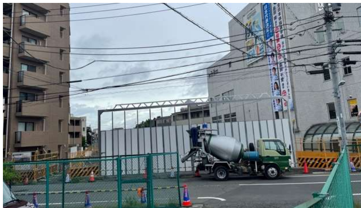
事業区間中間部付近
