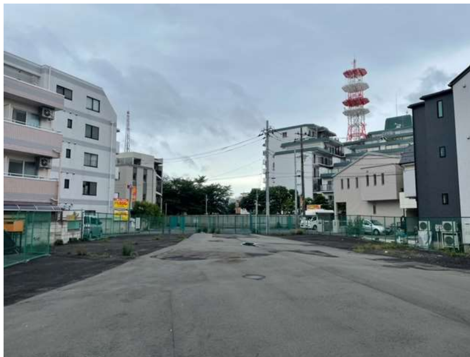
現況(事業区間中間部付近)
