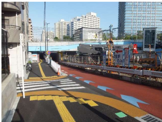
①現況(街路築造工事)
