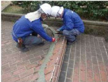
直営スタッフによるインターロッキングの応急補修
