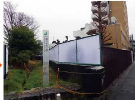
ポリカーボネートのフェンス設置
