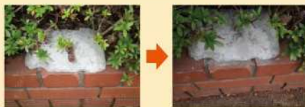
突き出た鉄筋の除去
