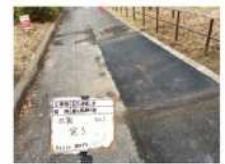
ランニングコース不陸解消工事
