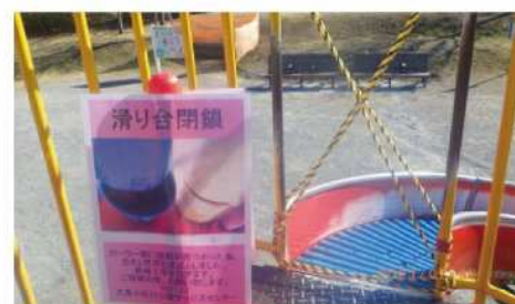
遊具の磨耗部品発見を受けた一時閉鎖措置
