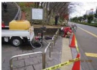
有孔管の高圧洗浄
