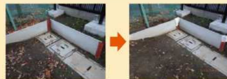
はみ出た鉄筋の緩衝材によるカバー
