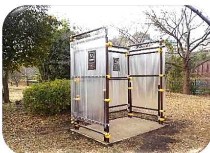
(左) 煙遮蔽板を設置した新喫煙所
