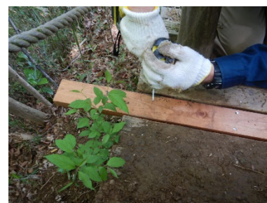
腐食防止塗装済の踏み板に交換
