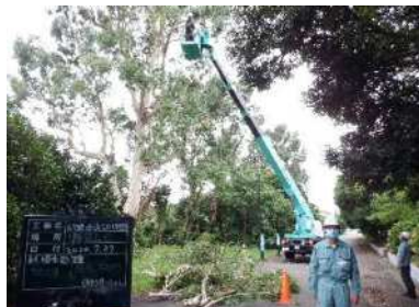
危険木伐採工事（作業中）
