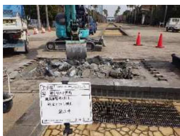
水中照明LED化工事状況
