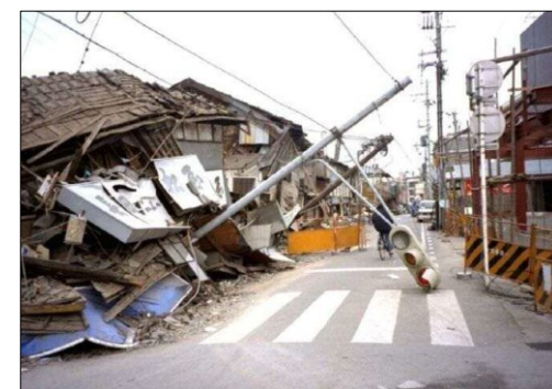
阪神・淡路大震災での倒壊電柱(国交省HP)
