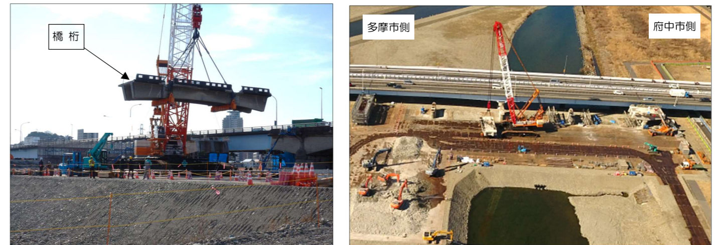
橋桁撤去状況（令和3年1月撮影）
