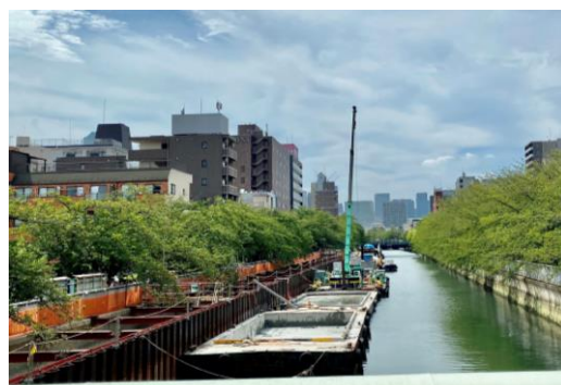
写真-2 桜並木に配慮した施工（仮締切時）
