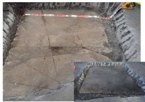
写真-3 水路躯体状況及び敷鉄板
