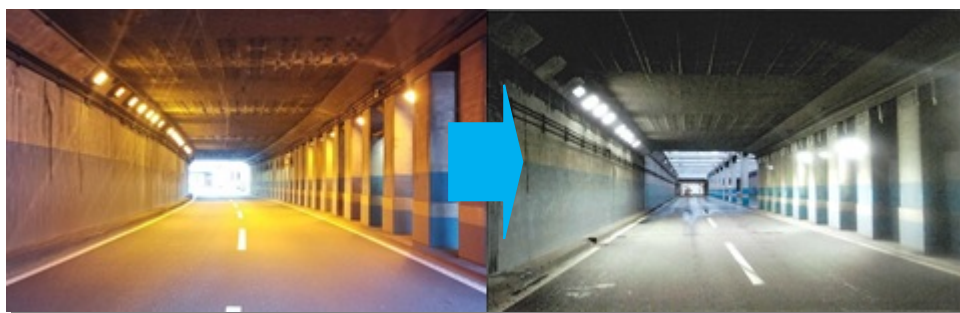
写真-1 トンネル照明改修前（左）、改修後（右）
