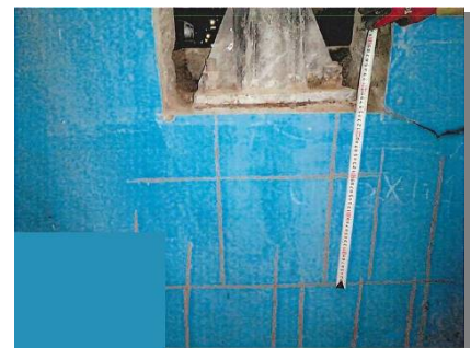
写真－5 坑外照明基礎部の状態
