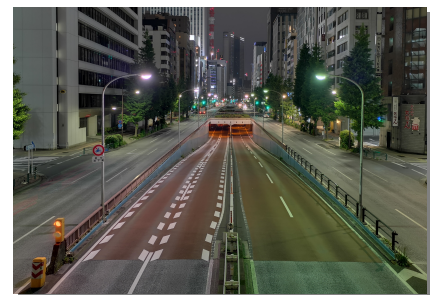
写真－4 地下自動車道出入口
