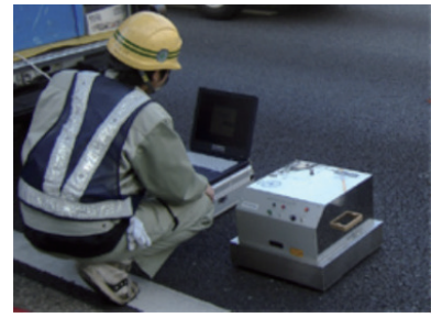
写真-3 CTメータによるきめ深さの測定状況
