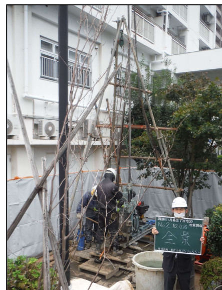
【保育園隣接箇所での作業状況】
