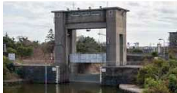
15 江戸川水閘門(篠崎水門)
