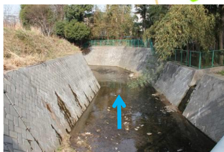
なか 中橋上流側
