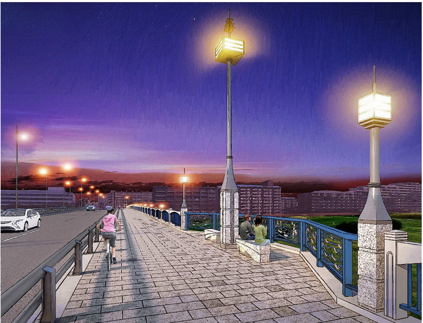
バルコニー周辺 (下流橋の歩道部から府中市側を望む)
