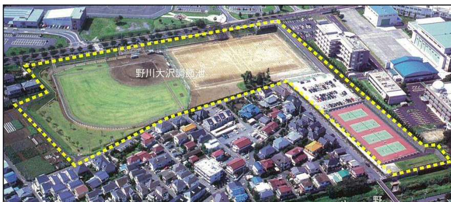
掘込式調節池の例(野川大沢調節池)
