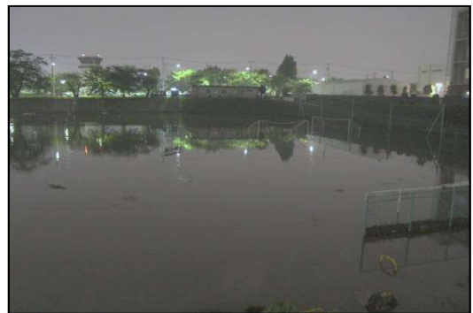
調節池への流入状況 (野川大沢調節池 平成25年8月12日)
