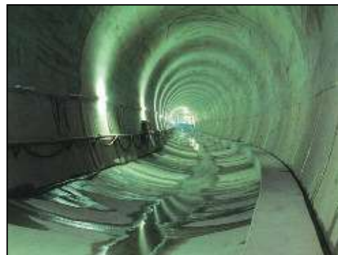
分水路の例(三沢川分水路)
