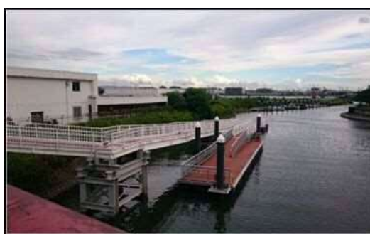
図 2-4 防災船着場（天空橋上流）
