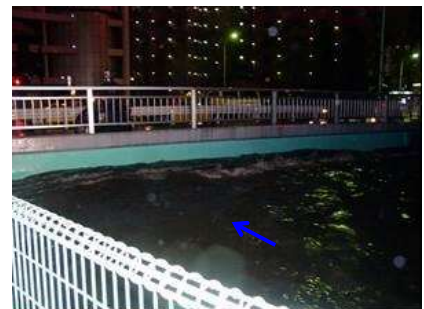
平成16年台風23号(古川橋)
