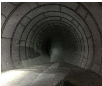
古川地下調節池内部
