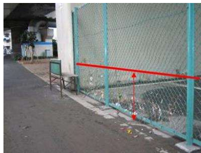
平成11年集中豪雨冠水痕跡(明治通り)
