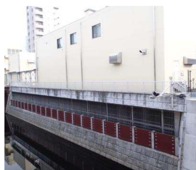
養老橋下流右岸取水口
