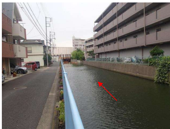
写真 4-1 洪水・高潮対策区間の現況（河口付近）
