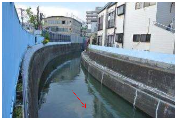
写真 2-6 桜橋より上流の河道の様子
