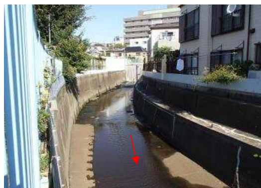
写真 2-4 立会川干潮時の様子
