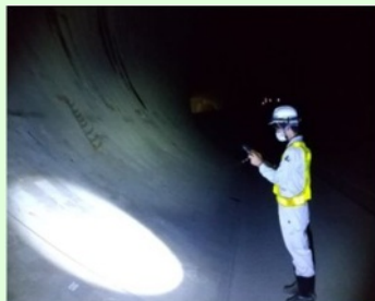
↑ 健全度調査実施状況(目視)
