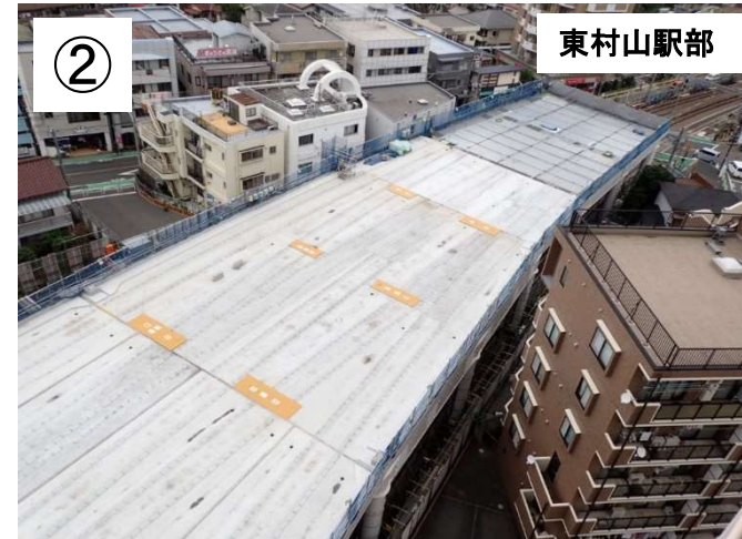
高架橋構築状況(直上施工)
