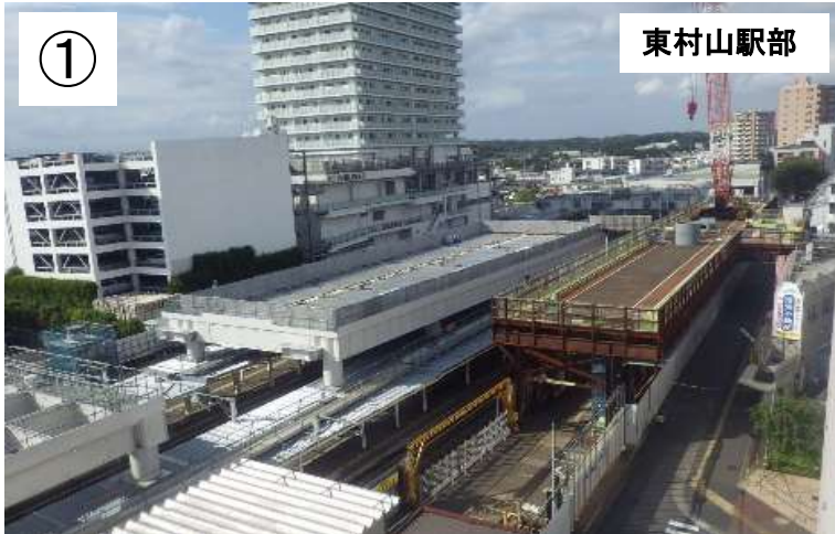
高架橋構築状況(直上施工)
