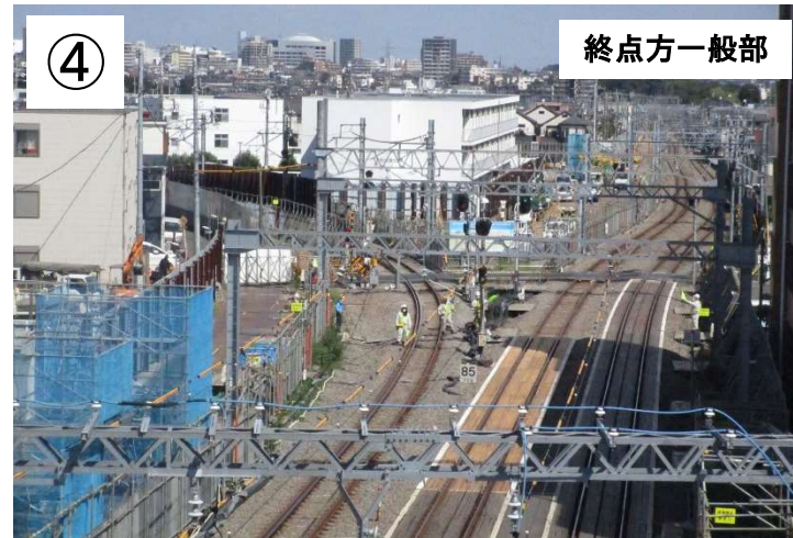
仮線切替完了状況
