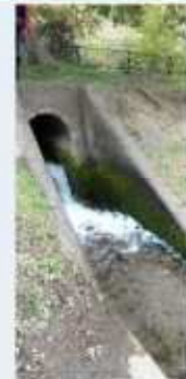
わき水広場放水口
