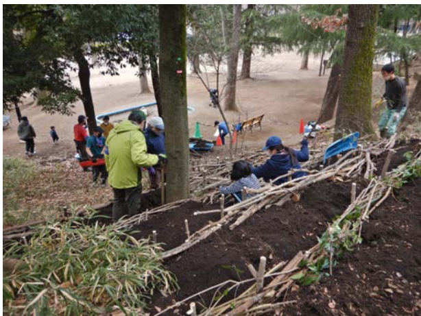
泥水の発生軽減のため、しがら柵と土の補充で植物の生育環境を回復
