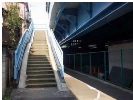
写真 1-1 階段の例 新神谷橋（北区～足立区）
