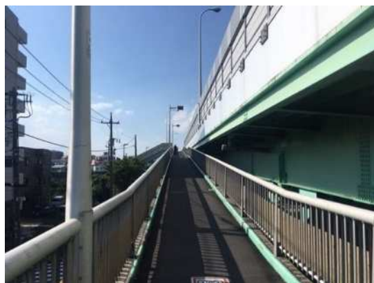
写真 1-3 長いスロープの例 青砥橋（葛飾区）
