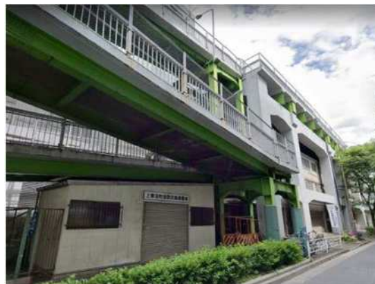
写真 1-2 急勾配のスロープの例 両大師橋（台東区）
