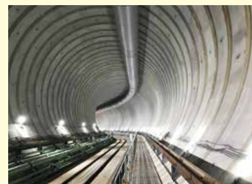
広域調節池シールドトンネル施工状況(内径12.5m)
