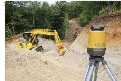
<山間部での掘削>
