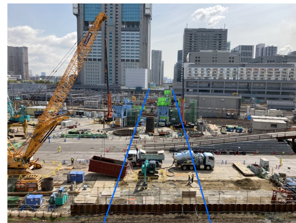
高輪方から見た鉄道区域での施工の様子(4月下旬撮影)。橋を支える柱(橋脚)の基礎をつくっています。(青色の線は将来の橋のおおよその位置)
