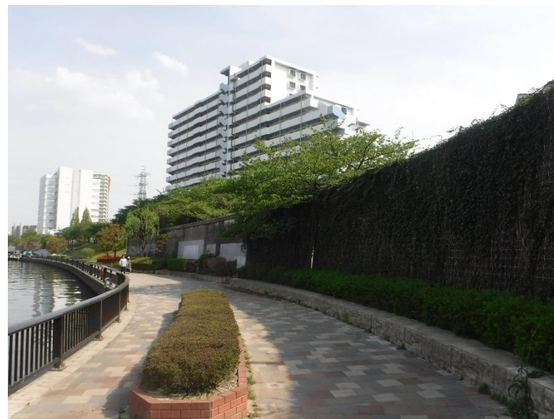
隅田川防潮堤
