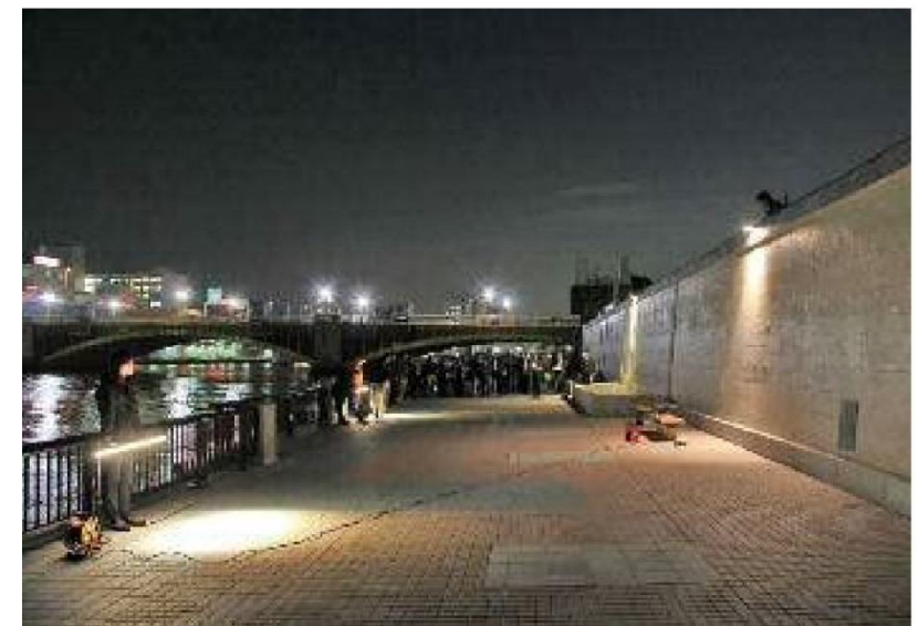
夜間照明の設置 (蔵前橋付近)
