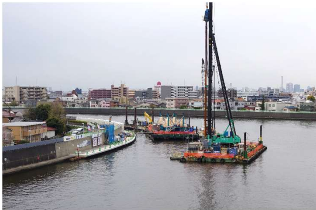
防潮堤耐震補強工事（中川）
