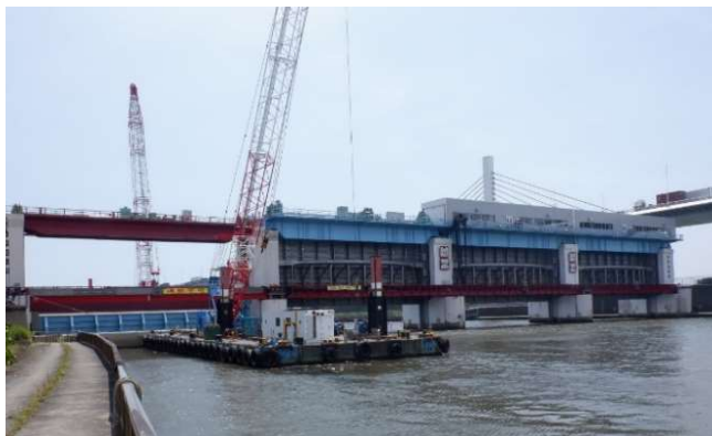
水門耐震補強工事（上平井水門）
