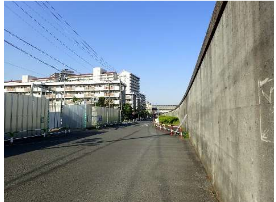
防潮堤（陸側からの視点）
