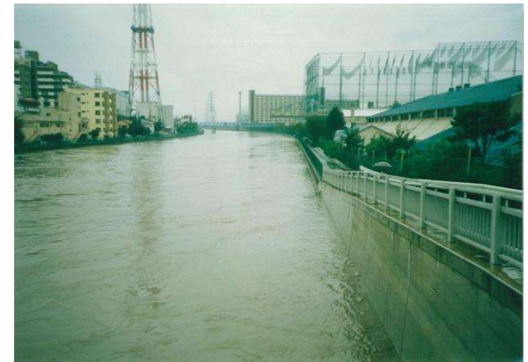
新河岸川西台橋付近の増水 (平成3年9月19日台風18号)
