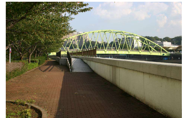
堤防整備の様子（北区浮間五丁目付近）
