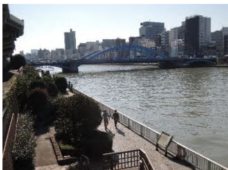
平常時の駒形橋上流左岸 (隅田川)
