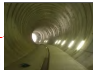
白子川地下調節池 【石神井川取水施設】 貯留率：86%
