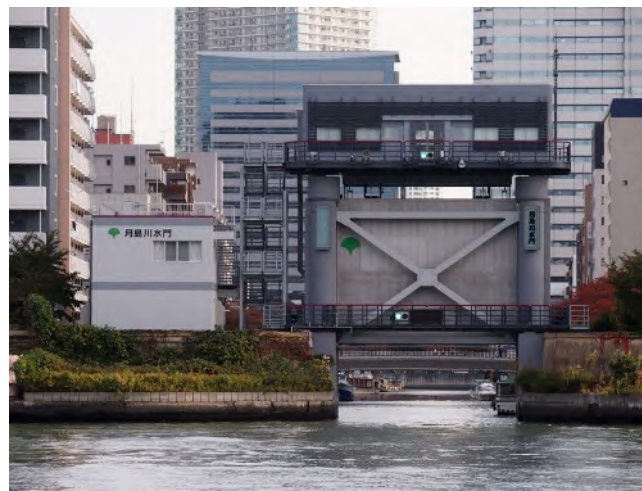
水門、排水機場等の新設・改良
