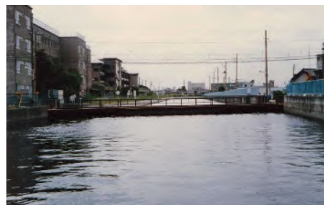
北十間川新小原橋付近（水位低下前）
