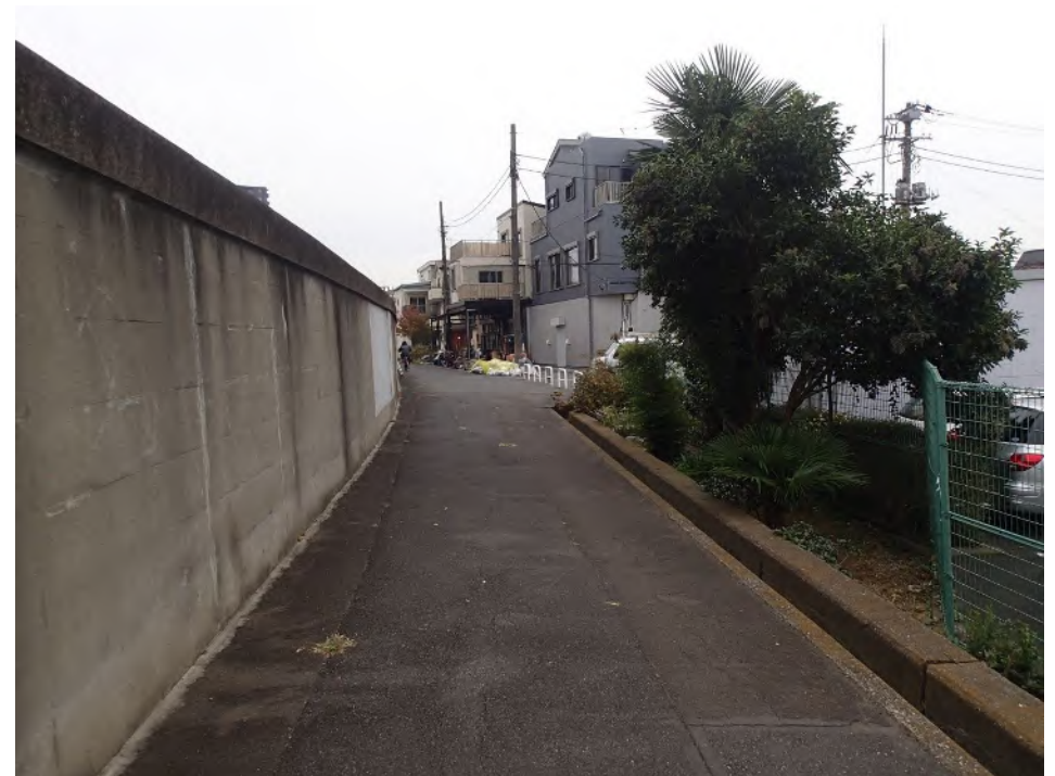
防潮堤の背後の状況（隅田川）
