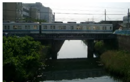
北十間川新小原橋付近（水位低下後）
