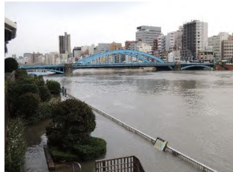
高潮時の駒形橋上流左岸 (隅田川)
