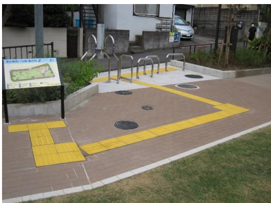
入口から案内板までの誘導ブロック。
