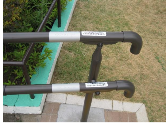
手摺端部の点字表示
