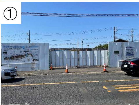
① 起点側(国分寺市側)
