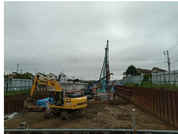
立体交差点付近(宇津木町側)の 擁壁設置工事状況
