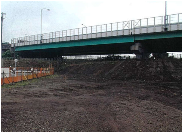
中央自動車道との交差点(施工前)
