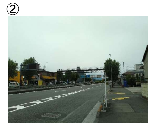
(国道16号線八王子バイパスの状況)
