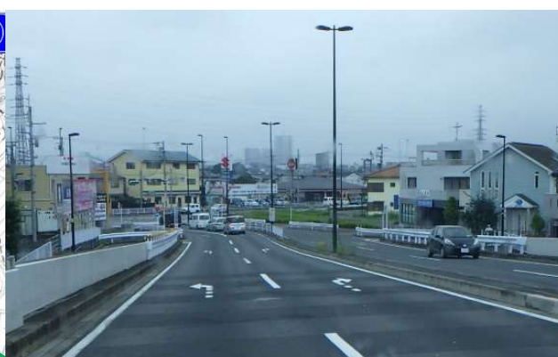
南多摩尾根幹線道路より終点部をのぞむ
