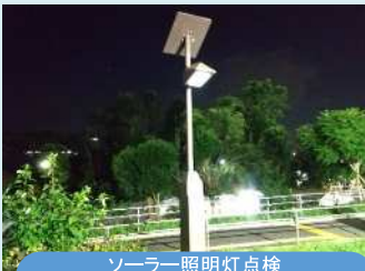
ソーラー照明灯点検 (防災施設の点検)
