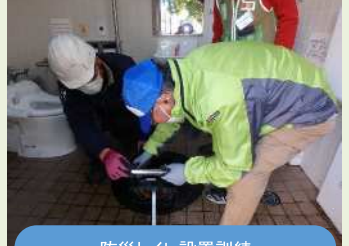
防災トイレ設置訓練
