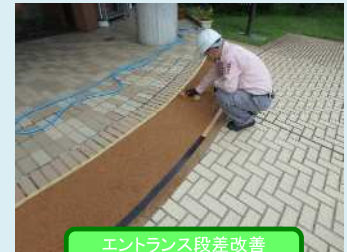
エントランス段差改善 (ゴムチップ舗装)
