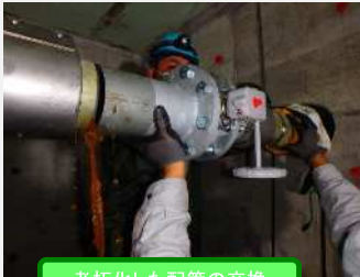
老朽化した配管の交換
