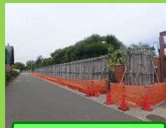
植物館前フェンス設置状況
