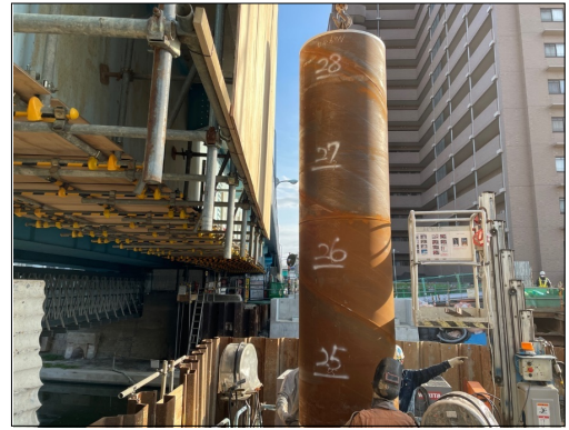
(写真-2) 構造物と近接した基礎杭施工状況
