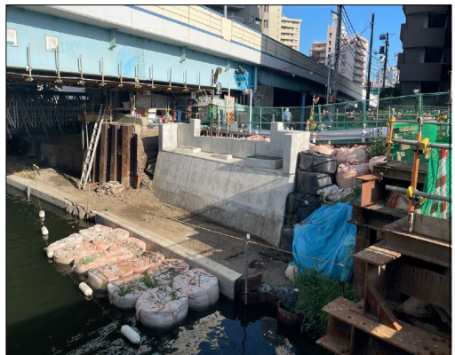
(写真-5) A1 橋台施工完了状況
