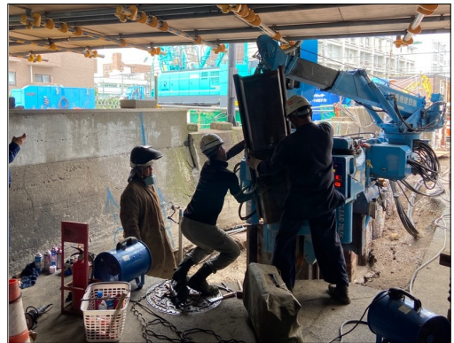
(写真-3) 上空制限下での鋼矢板打込み状況
