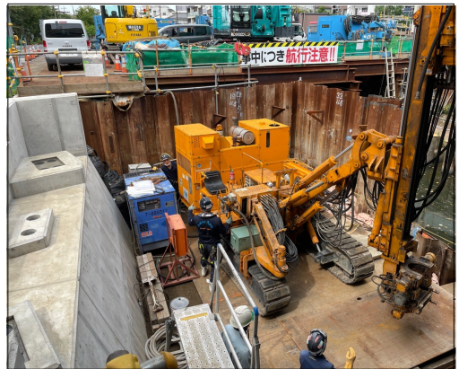
(写真-4) 小型ドリル配置状況
