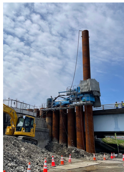
写真-1 鋼管杭圧入状況
