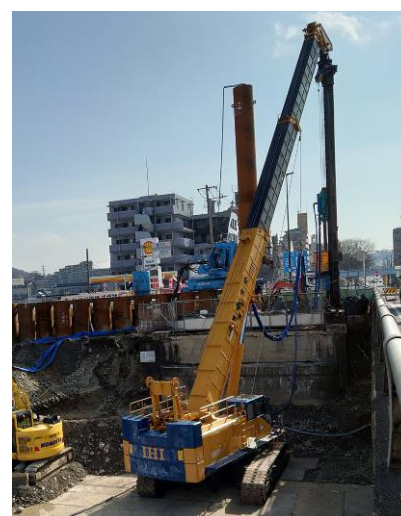
写真-2 ロックオーガー施工状況
