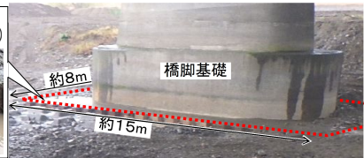
写真-2 明らかとなった旧橋の洗堀防止対策状況
