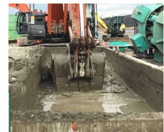
写真-4 泥土処分状況
