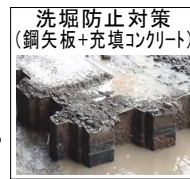
写真-2 明らかとなった旧橋の洗堀防止対策状況
