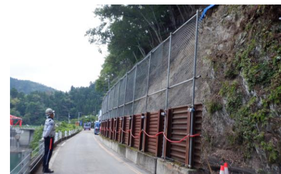
写真－3 片側交互通行規制状況
