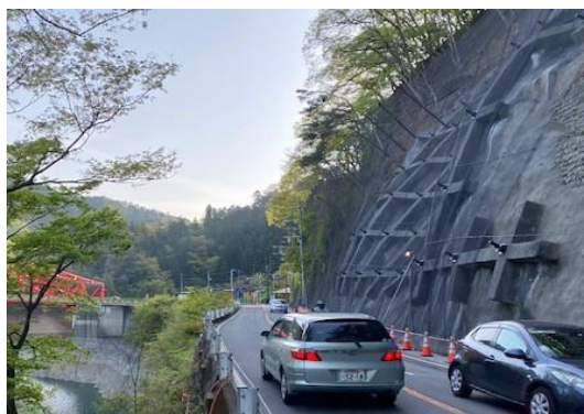
写真-5 交通開放直後の様子
