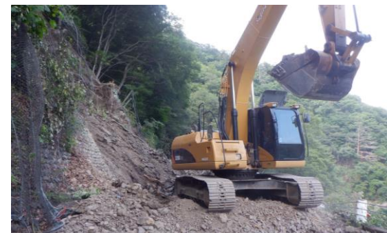
写真－2 崩落土砂撤去状況
