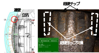
図-6 点検位置 写真-4 最外周ビット損傷状況
