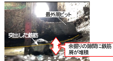
写真-3 切削面の状況
