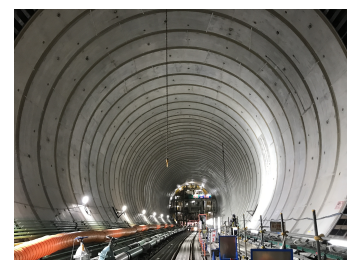
写真-5 シールドマシン掘進状況
