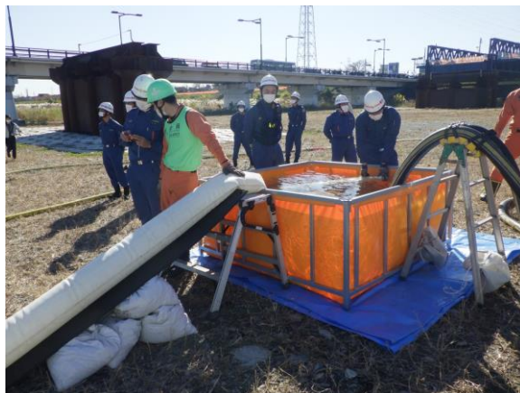
写真－2 中継水槽における排水ホースの設置状況
