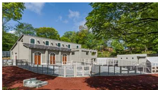
写真－３ 完成したキリン舎
