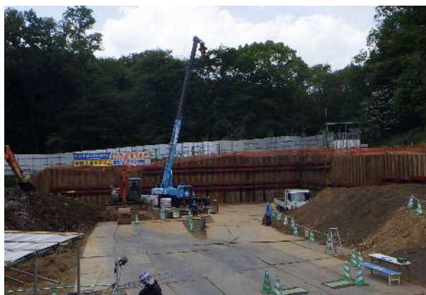
写真－１ 山留工事の状況
