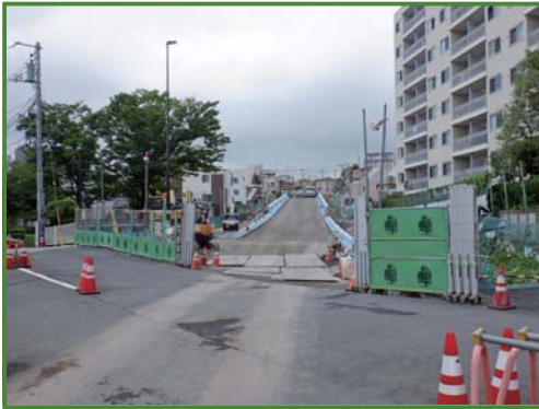
施工中写真 (令和4年6月時点)
