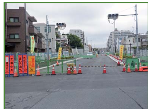
施工中写真 (令和4年6月時点)
