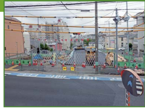
施工中写真 (令和4年6月時点)
