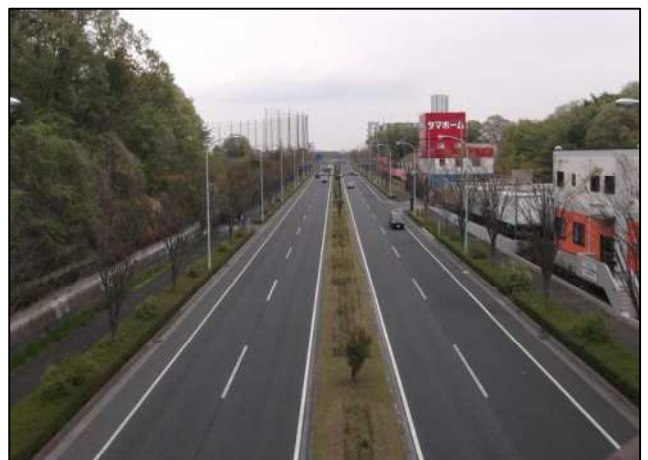
完成区間 (4車線) の状況 (八王子市別所地区)
