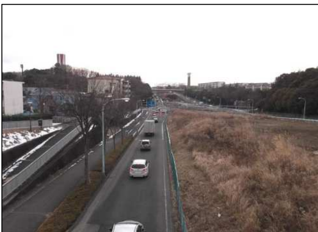
暫定2車線区間の状況 (多摩市豊ヶ丘地区)
