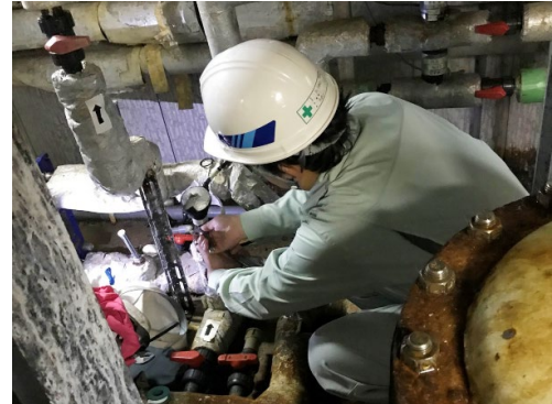
配管等の点検作業
