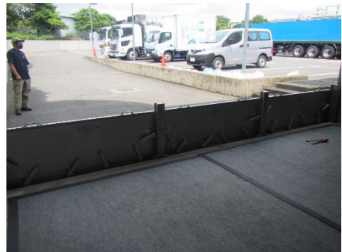
ゲリラ豪雨に備えた止水板設置訓練
